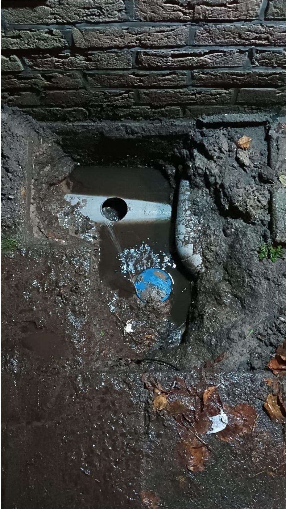
(foto – Gat in het riool waardoor is schoongemaakt)
