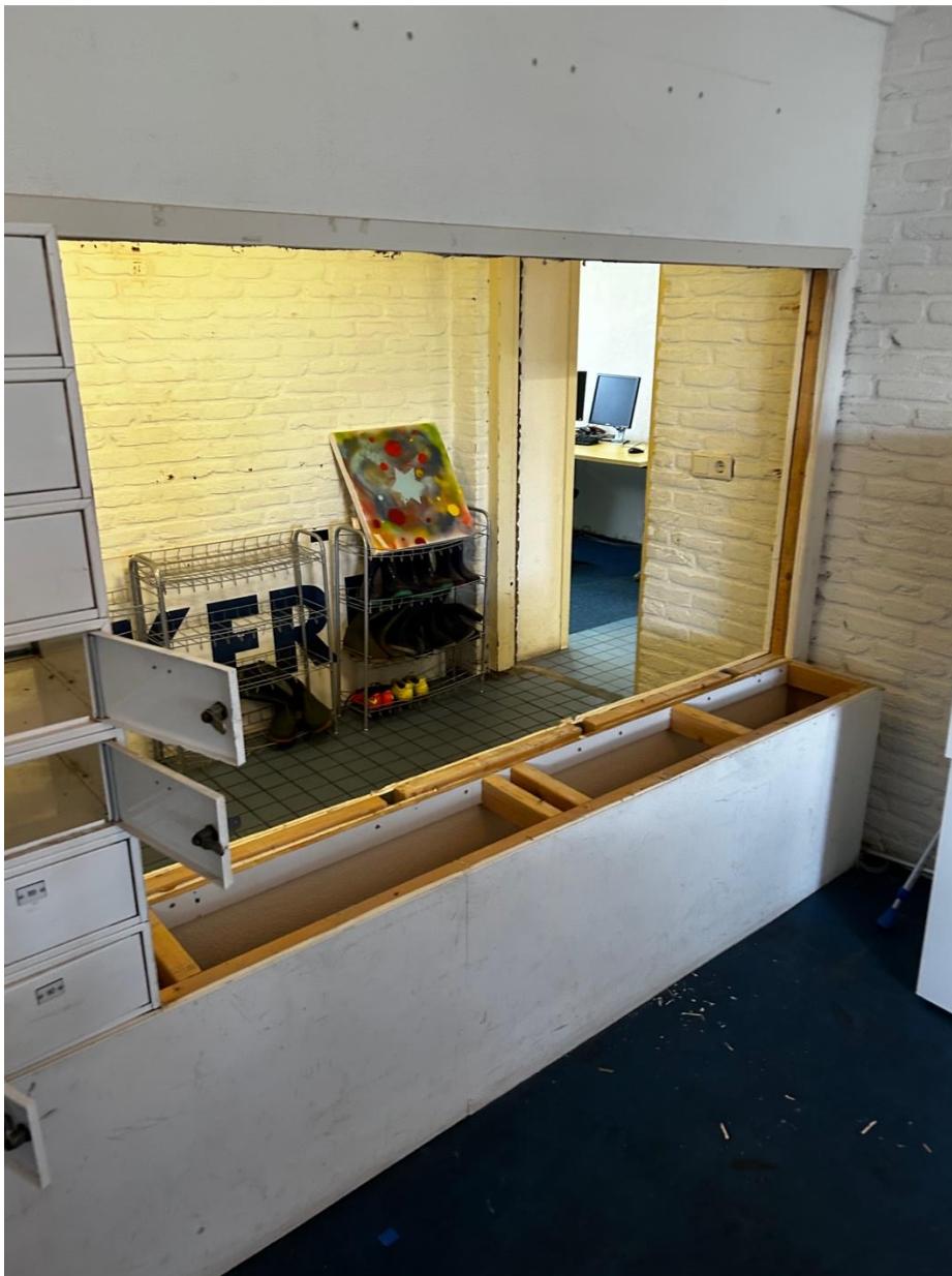
(foto – Verbouwing commissiekamer)
